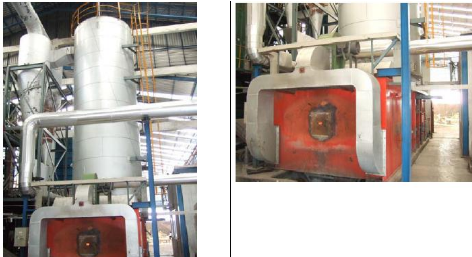
รูปที่ 6.76 หม้อน้ำร้อนขนาด 10.8 ล้าน kCal/ชั่วโมง
