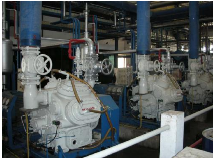
รูปที่ 6.17 คอมเพรสเซอร์ชนิดลูกสูบ 119 kW จำนวน 3 ตัว
