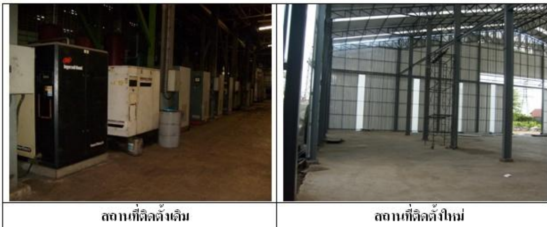
รูปที่ 6.62 สถานที่ติดตั้งเครื่องอัดอากาศก่อนและหลังดำเนินการปรับปรุง
