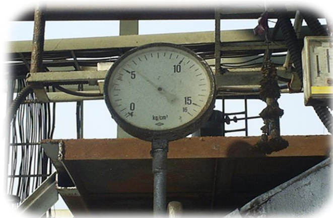
รูปที่ 6.48 การปรับตั้งความดันไอน้ำที่ 6 บาร์เกจ
