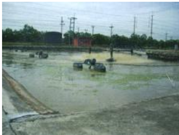
รูปที่ 6.69 ระบบบำบัดน้ำเสียแบบสระเติมอากาศเดิมของโรงงาน
