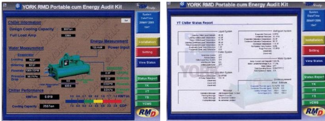
รูปที่ 6.79 (ซ้าย) การควบคุมการทำงานด้วยคอมพิวเตอร์ (ขวา) จอรายงานผลการทำงานของ Chiller
