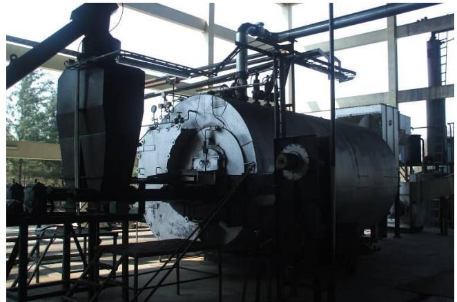
รูปที่ 6.46 หม้อไอน้ำขนาด 16 Ton (ด้านซ้าย) และ 10 Ton (ด้านขวา)
