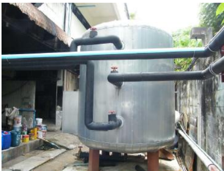
รูปที่ 6.85 ถังเก็บน้ำร้อนขนาด 10,000 ลิตร
