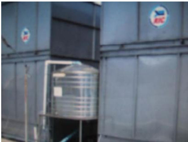
รูปที่ 6.19 Evaporative Condenser
