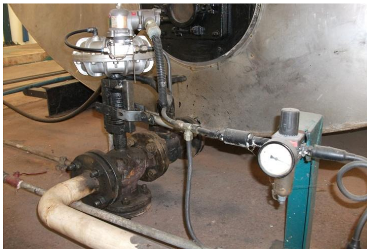
รูปที่ 6.45 การระบายน้ำทิ้งของ Boiler
