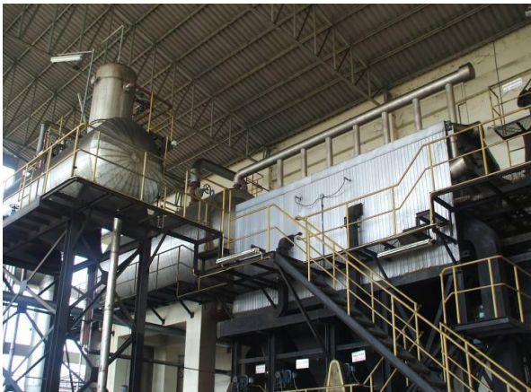
รูปที่ 6.46 หม้อไอน้ำขนาด 16 Ton (ด้านซ้าย) และ 10 Ton (ด้านขวา)
