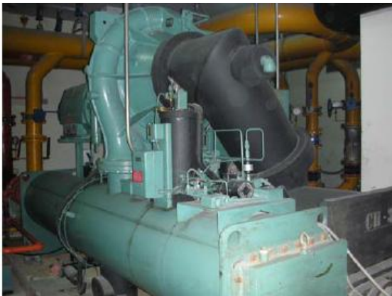
รูปที่ 6.78 (ซ้าย) Chiller 300 ตัน และ (ขวา) VSD ควบคุมเครื่องทำความเย็น
