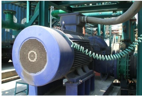
รูปที่ 6.57 มอเตอร์ที่ใช้ในการขับน้ำหล่อเย็นเพื่อระบายความร้อนให้ส่วนการผลิต
