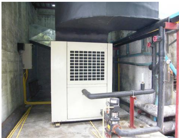
รูปที่ 6.84 (ซ้าย) Heat Pump เครื่องที่ 1 (ขวา) Heat Pump เครื่องที่ 2
