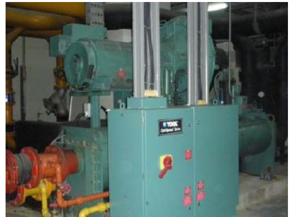
รูปที่ 6.78 (ซ้าย) Chiller 300 ตัน และ (ขวา) VSD ควบคุมเครื่องทำความเย็น
