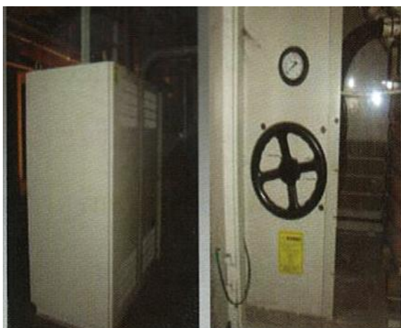
รูปที่ 6.68 Voltage Regulator ที่ติดตั้งใช้งานในอาคาร
