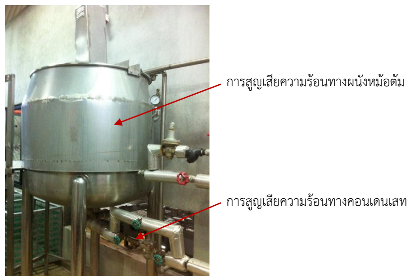
รูปที่ 5.6 แสดงการสูญเสียพลังงานความร้อนของหม้อต้ม
