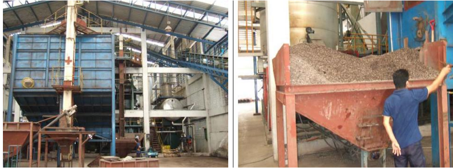
รูปที่ 6.74 ฮอปเปอร์ป้อนเชื้อเพลิงชีวมวล
